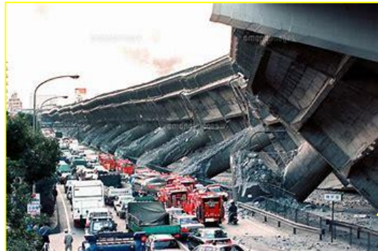
阪神・淡路大震災において 倒壊した阪神高速道路
