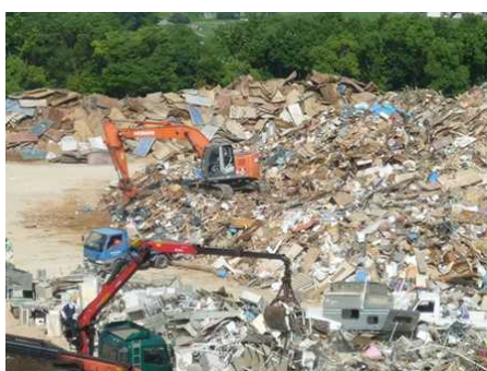
災害廃棄物の仮置場の管理
