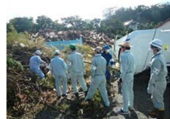
災害廃棄物の収集運搬にかかる助言の様子 写真提供：東京都
