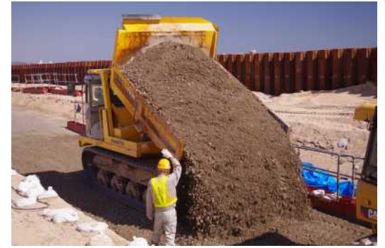
いわき市海岸堤防復旧事業(H25.3.15～本格開始)
