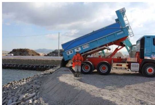
仙台塩釜港石巻港区廃棄物埋立護岸整備事業 (H25 年 2 月 20 日～開始)
