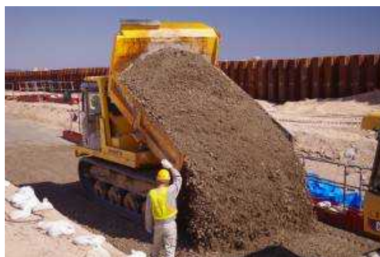
いわき市海岸堤防復旧事業 (H25. 3. 15～本格開始)
