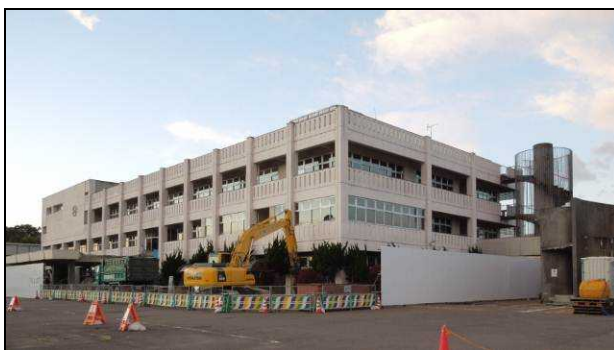
解体前（H24 年 11 月 14 日撮影）
