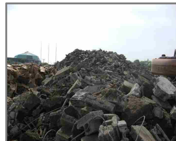
仮置状況(コンクリートブロック)
