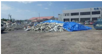
9/25 南房総市市役所東側駐車場仮置場
