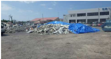
9/25 南房総市市役所東側駐車場仮置場
