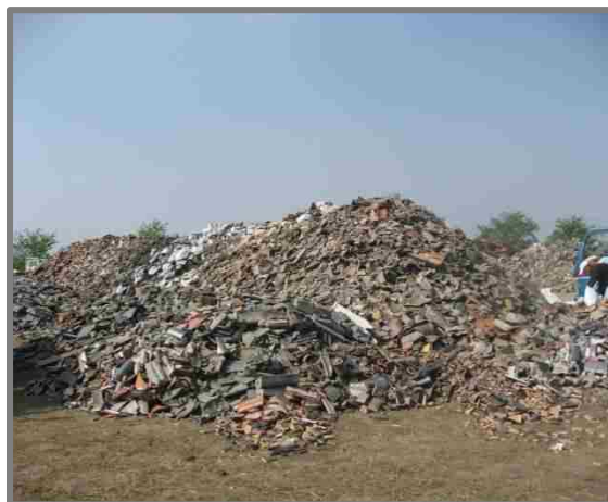
仮置状況(瓦等)
