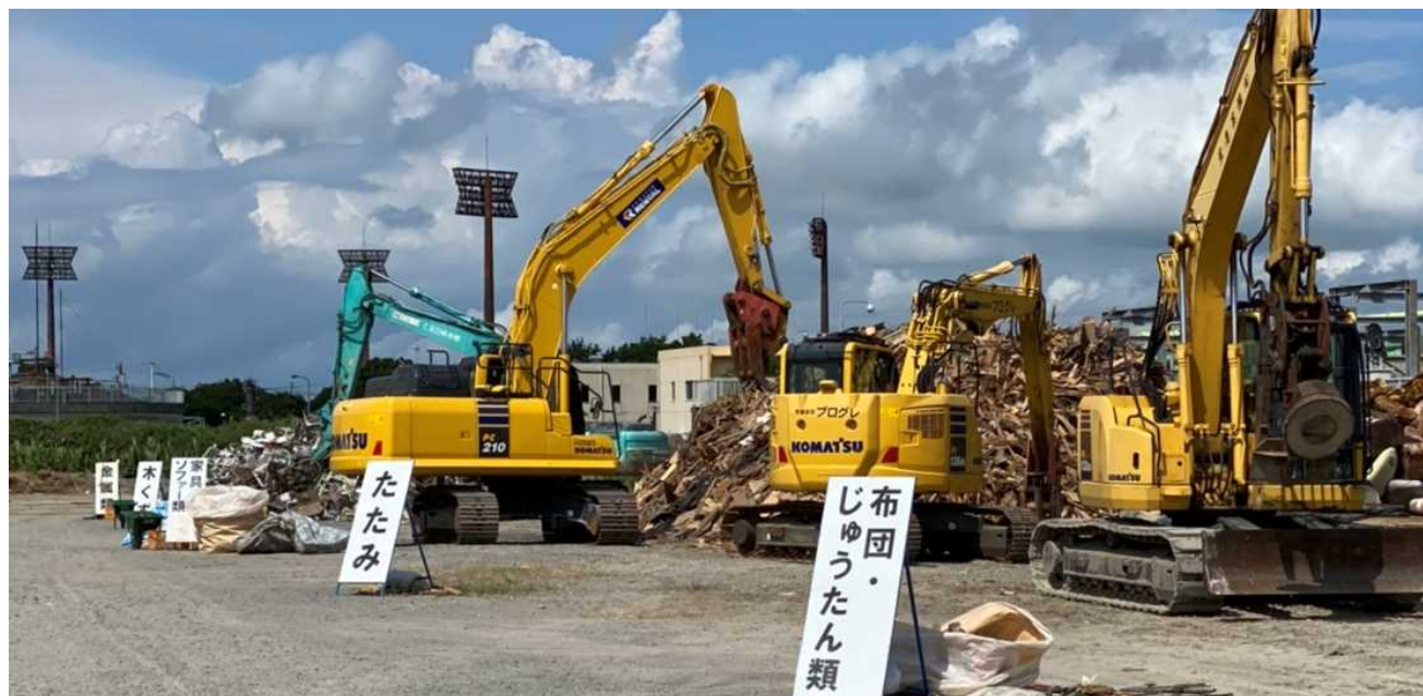
【仮置場全景写真】
