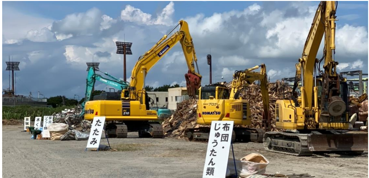
【仮置場全景写真】
