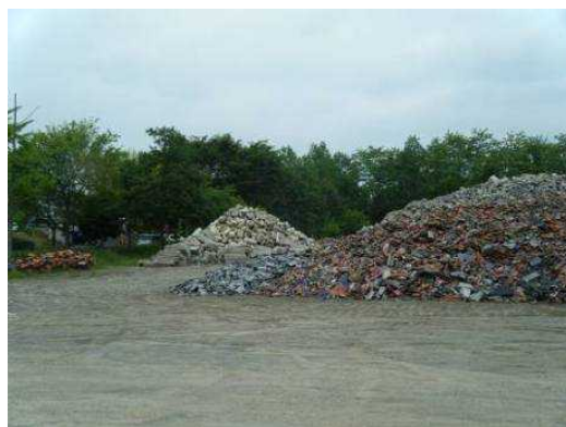
分別保管された屋根瓦(手前) (利府町)
