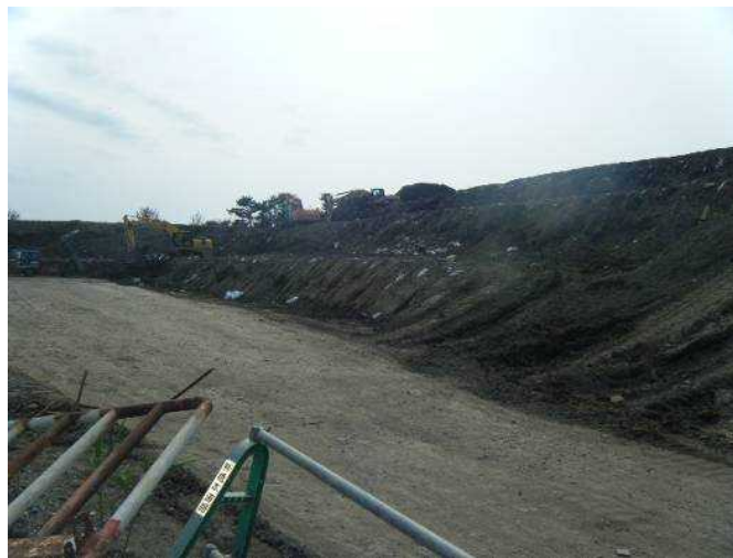
土壌改良され保管された津波堆積物
