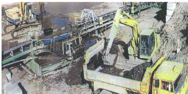
水槽分離施設での作業の様子
