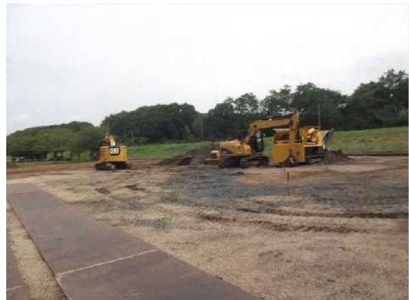
土砂の入れ替え工事 (宝堀球場)
