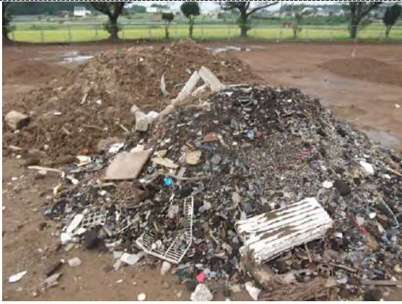
選別した廃棄物の仮置き (宝堀球場)
