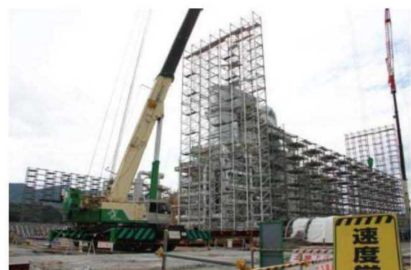
解体中(撮影日H25.9.26)
