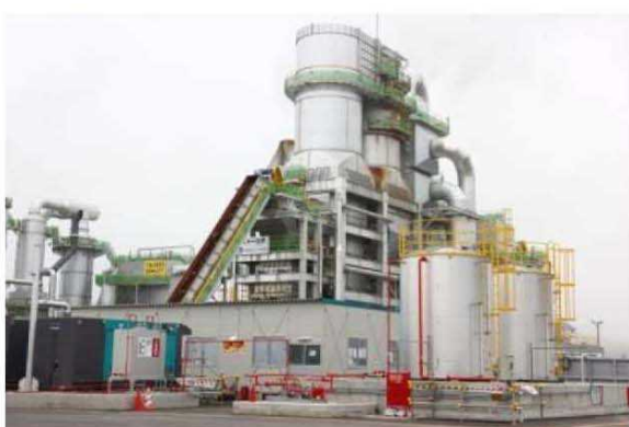
解体前(撮影日H25.5.16)
