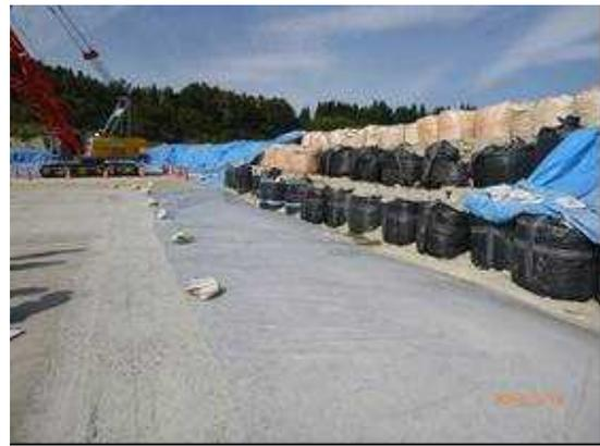
土壌層敷設後の飛灰の埋立作業
