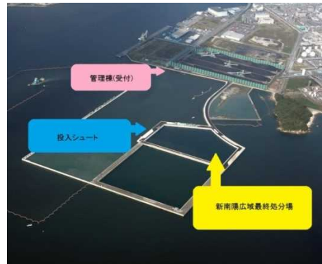
徳山下松港新南陽広域最終処分場
